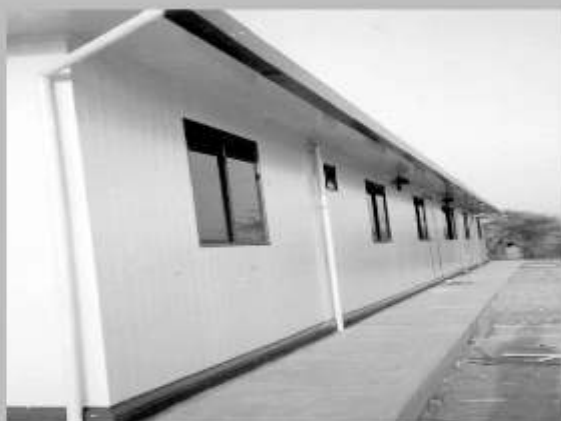
VISTA LATERAL DE OFICINAS
